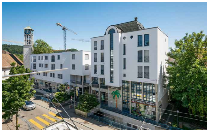
Neuhausen am Rheinfalt, Wildenstr. 1-5, Zentralstr. 9 Immeuble à usage mixte
