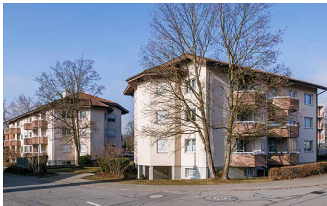
Aarau, Heuweg 3-7 Immeuble résidentiel
