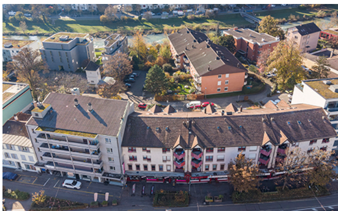
Birsfelden, Hauptstrasse 84, 86, 88, Muttenerstrasse 2, Weidenweg 8, 8a, 10
